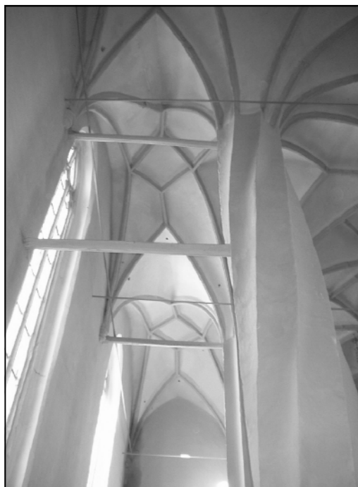
Fig. 3.b. Sistem boltire; traveele vest - colaterala sud
