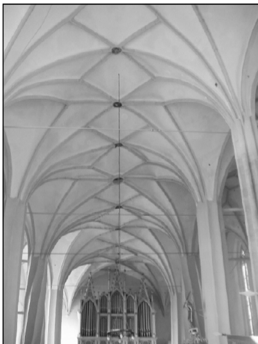
Fig. 3.a. Sistem boltire; nava centrală
