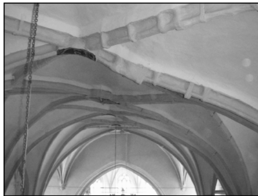
Fig. 3.d. Bolțile navei centrale; detaliu deformări și intervenții 1919
